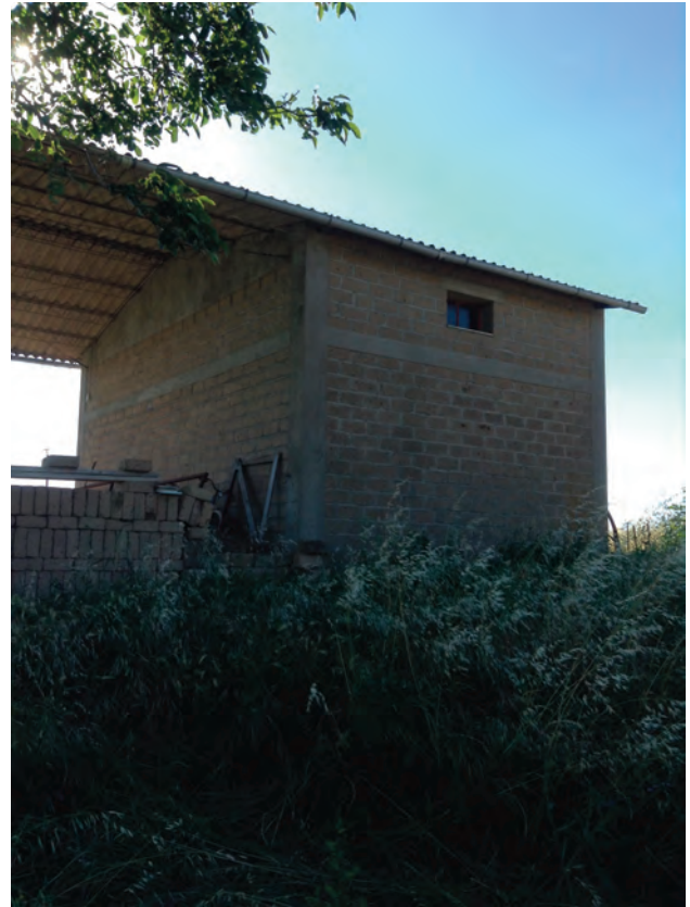
unità edilizia: A 007B2
